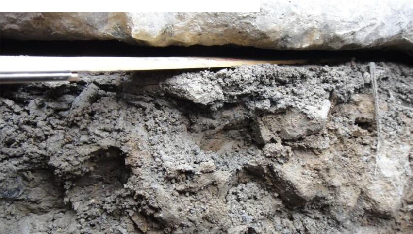
Fig. 7: élasticité fortement réduite du lit de ballast et traverses danseuses déjà existantes: espace vide entre l'AI de traverse et le lit de ballast; beaucoup de concassé de ballast et d'abrasion des grains; bourrage plus vraiment efficace
