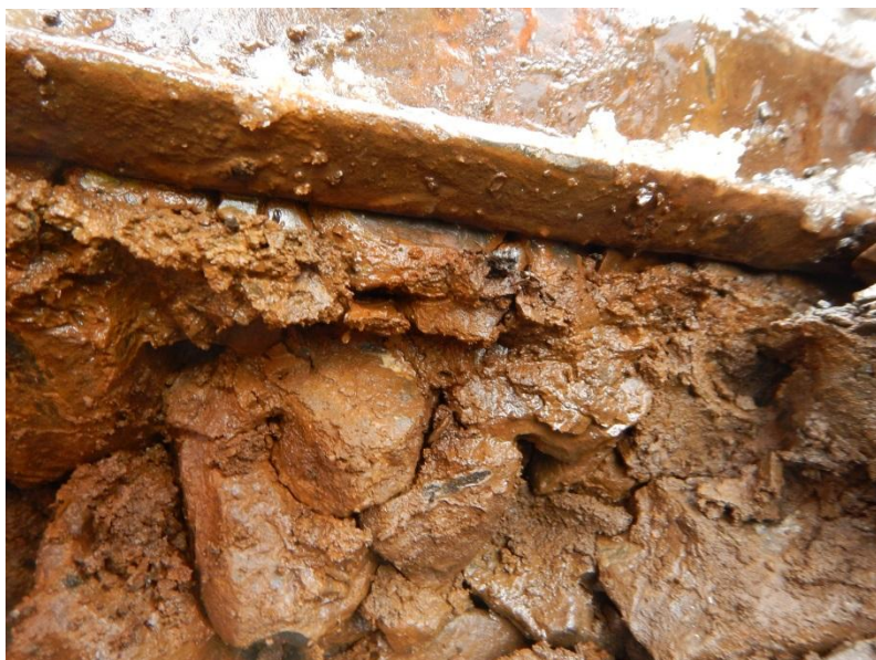
Fig. 3 und 4: niveau avancé de solidification sous les traverses; vides très petits; concassé de ballast et abrasion des grains se déposent; grandes surfaces de contact; élasticité fortement réduite dans le lit de ballast; en conséquence un espace vide se forme entre l'arête inférieure des traverses et le lit de ballast, ce sont des traverses danseuses (affaissement lors du passage d'un train ne se déroule qu'au-dessus du lit de ballast); bourrage doit avoir lieu à court terme
