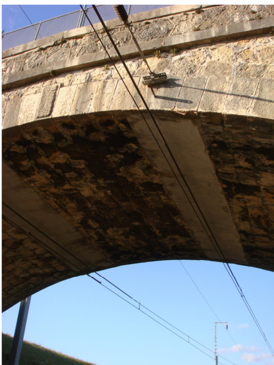
Fig. 16: Ev. détail: fixation de la ligne de contact sur un passage supérieur (indication de la possibilité de rehaussement)
