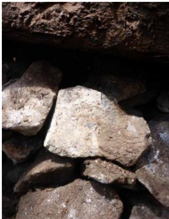
Fig. 2: début de solidification (orientation latéralement des grains) sous les traverses unterhalb der Schwellen; vides diminuent; surfaces de contact deviennent plus grandes; élasticité réduite dans le lit de ballast; bourrage doit à moyen terme décaler cette solidification
