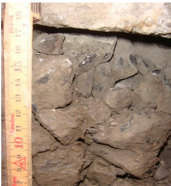
Fig. 3 und 4: niveau avancé de solidification sous les traverses; vides très petits; concassé de ballast et abrasion des grains se déposent; grandes surfaces de contact; élasticité fortement réduite dans le lit de ballast; en conséquence un espace vide se forme entre l'arête inférieure des traverses et le lit de ballast, ce sont des traverses danseuses (affaissement lors du passage d'un train ne se déroule qu'au-dessus du lit de ballast); bourrage doit avoir lieu à court terme
