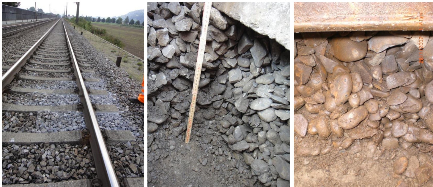
Fig. 3 - 5: Ev. détails du ballast: particularités comme les endroits blancs // „Schotterfliessen“ (gauche), zone de bourrage (milieu) et part importante de grains ronds (droite)
