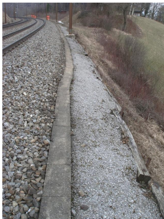
Fig. 15: Ev. détail: caniveau à câbles qui glisse / support de banquettes qui glisse
