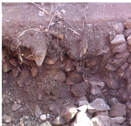
Fig. 4: Catégorie de criblage S2 (moyennement à beaucoup de déchets d'exploitation et moyennement de concassés de ballast) ; surtout plantes visibles au-dessus De plus: granularité suffisante, quelques grains ronds autrement arêtes arrondies Criblage possible, mais ne fait sens seulement si la voie a atteint une durée de vie suffisante et la charge future sera similaire.
