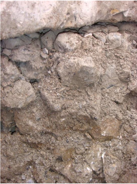
Fig. 5: avec un niveau avancé de solidification et la formation de traverses danseuses (espace libre entre l'AI de traverse et le lit de ballast), la plupart des grains de ballast sont cassés dans la zone de bourrage; bourrage doit avoir lieu à court terme mais seulement relativement efficace (existence de grains)
