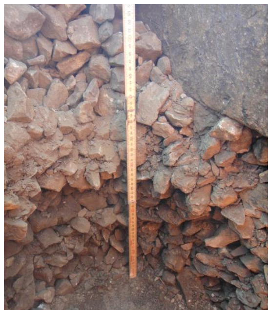
Fig. 4: catégorie de ballast S1-2 (peu à moyennement de déchets d'exploitation et de concassé de ballast, dans la zone de bourrage S2). Dans le zone de bourrage encore tous les grains de ballast disponibles et donc bourrage encore efficace .
