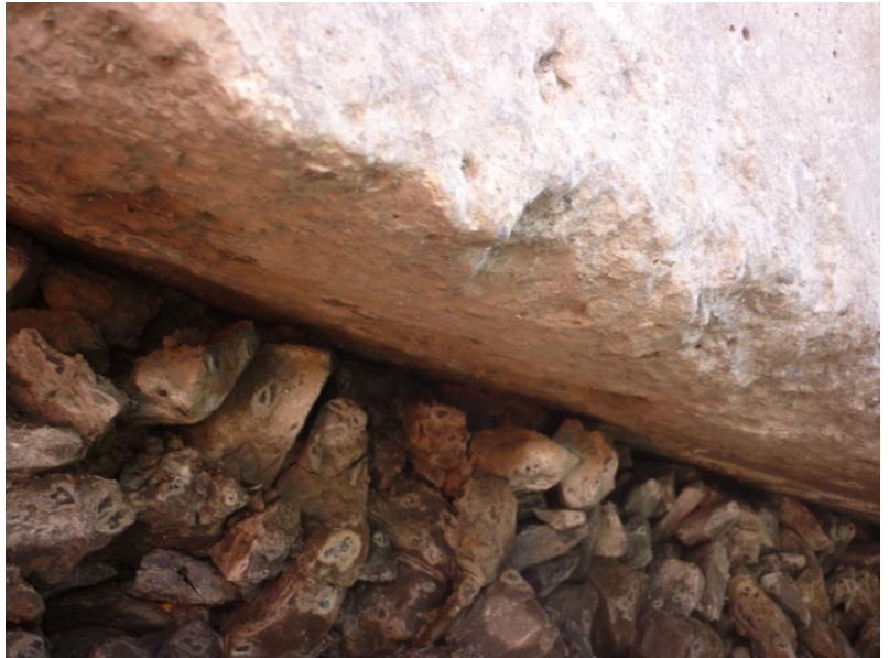
Fig. 6: vue de la zone de charge sous la traverse dans le cas d'une élasticité réduite du lit de ballast et traverses danseuses déjà existantes: espace vide entre l'AI de traverse et le lit de ballast: peu de déchets d'exploitation et concassé de ballast; justement pas la zone la plus pertinente pour l'appréciation de la nécessité à bourrer et l'aptitude au bourrage.
