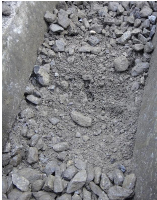
Fig. 1: catégorie de criblage S2 (peu de déchets d'exploitation et beaucoup de concassé de ballast dans la zone de bourrage) pores remplis par des particules fines non cohésives resp. du sable; plus assez de grains de ballast dans la zone de bourrage donc bourrage plus vraiment efficace
